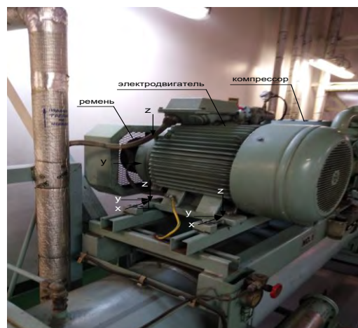
Рис. 3. Фото холодильной установки с указанием точек контроля и направление
