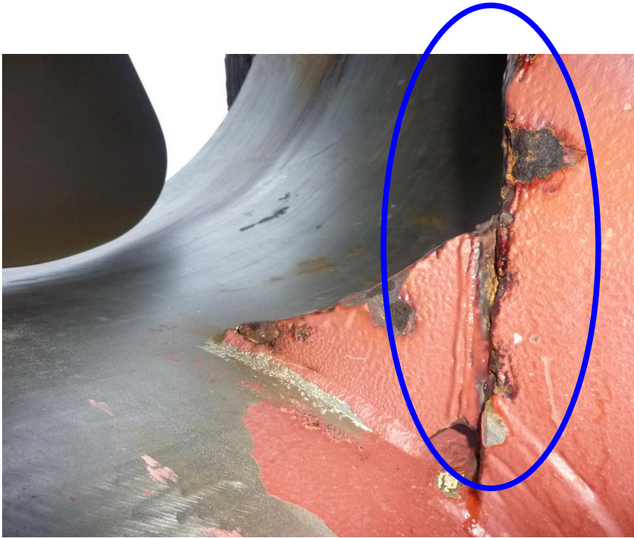
Трещина крепления насадки винта
